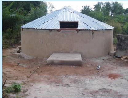
La construction d'une citerne à eau pour l'école de Koépédo.
